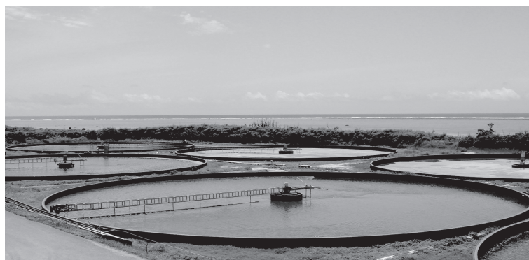
(b) 大規模開放式円形培養槽 (八重山殖産(株) 45) 沖縄県石垣島; 著者撮影)
