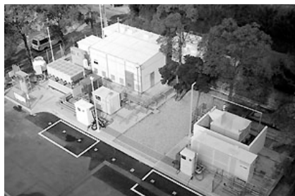
図表8 水電解法によるオンサイト水素製造型の水素供給ステーション 14)
