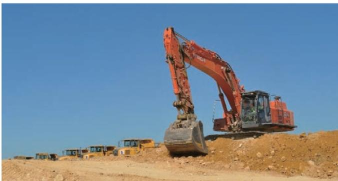
サイト中央では、パワー・シャベルがトカマクピットにおいて23万立方メートルの掘削を開始
