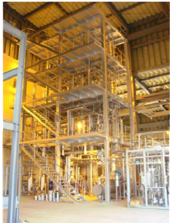
常圧・減圧もろみ塔(2: 日 x 2塔) 濃縮塔(4: 日)
