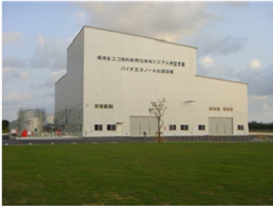
バイオエタノール生産設備全景
