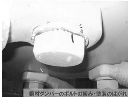
鋼材ダンパーのボルトの緩み・塗装のはがれ
