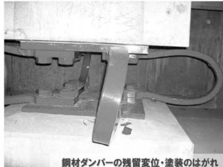
鋼材ダンパーの残留変位・塗装のはがれ
